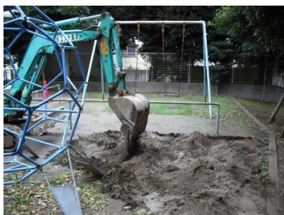
重機による土の掘り起こし
