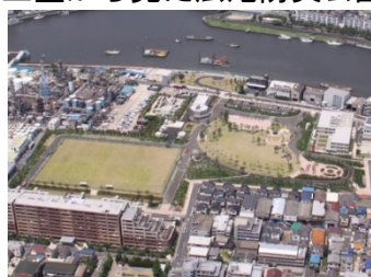
上空から見た広尾防災公園
