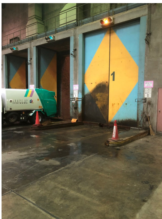
図2 プラットホーム写真
