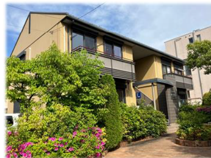
断熱改修を行う 既存賃貸集合住宅
