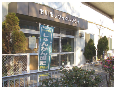
市川市リサイクルプラザ
