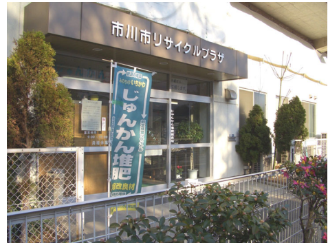
市川市リサイクルプラザ
