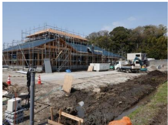
ドライブイン建設中：2024 年 4 月 1 日
