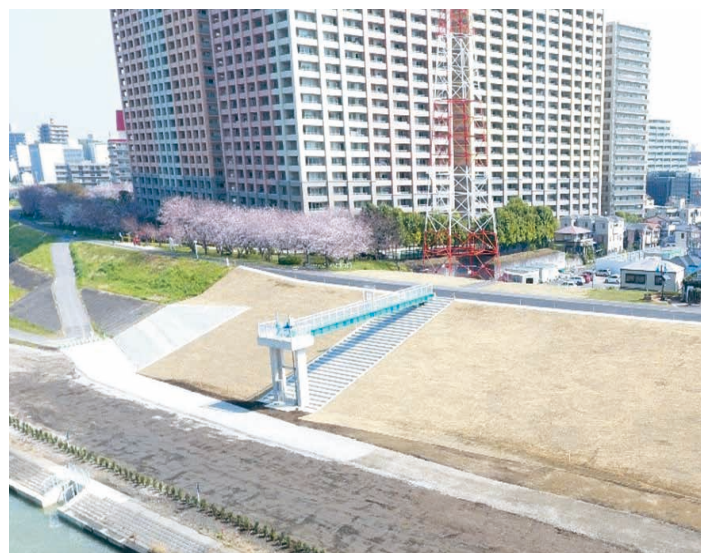
△市川南排水樋管建設工事委託（完成）
