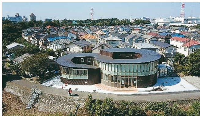
△上空から見た外観
