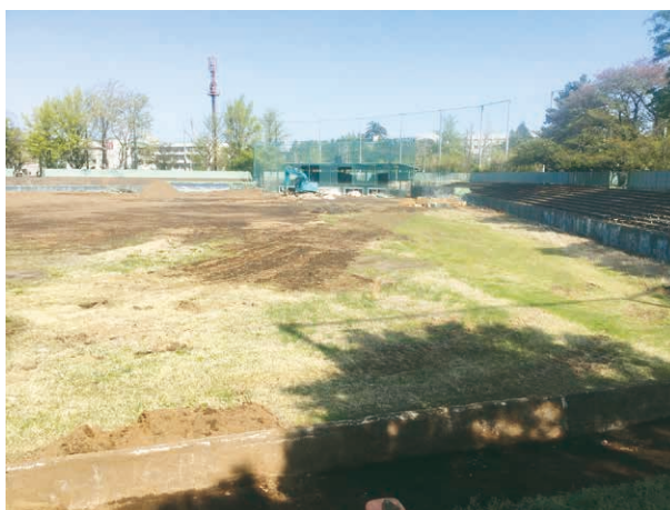
△グラウンド内状況
