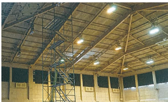
△信篤市民体育館高天井照明修繕
