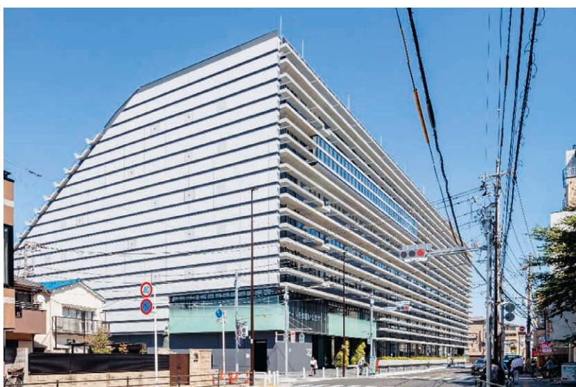
△国道14号から見た第1庁舎
