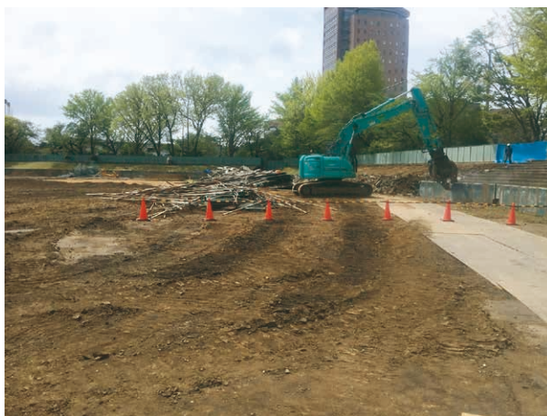
△フェンス解体
