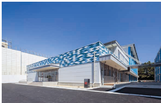
△（屋内運動場棟）令和2年8月供用開始
