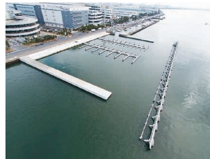
△第Ⅰ期工事完成
