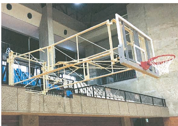
△国府台市民体育館バスケットボールゴール修繕
