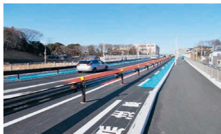
△開通後の状況
