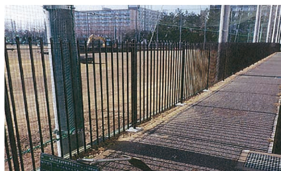
△塩浜市民体育館南側フェンス改修修繕
