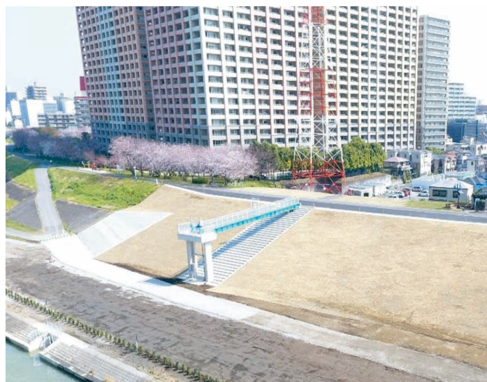
△市川南排水樋管建設工事委託（完成）
