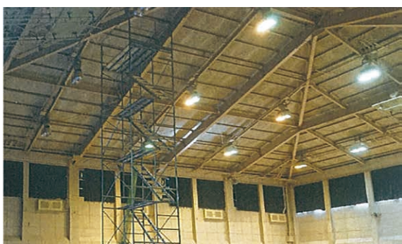
△信篤市民体育館高天井照明修繕
