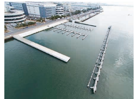
△第1期工事完成
