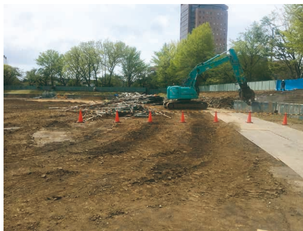
△フェンス解体
