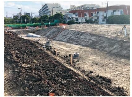
△施工中（令和3年3月末現在）
