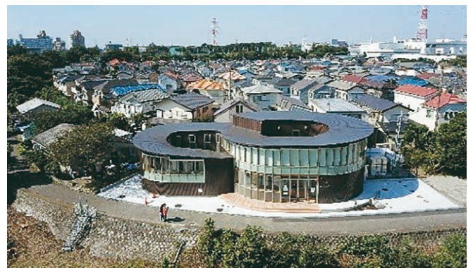
△上空から見た外観
