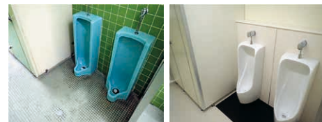
南行徳中学校トイレ改修工事 ▽改修前 ▽改修後
