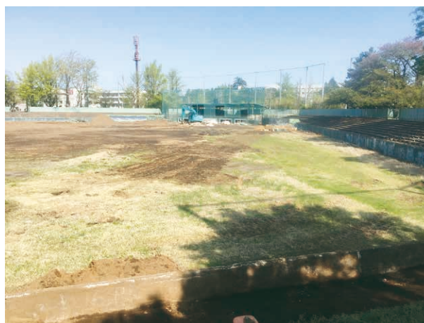
△グラウンド内状況
