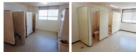
幸小学校トイレ改修工事 ▽改修前 ▽改修後
