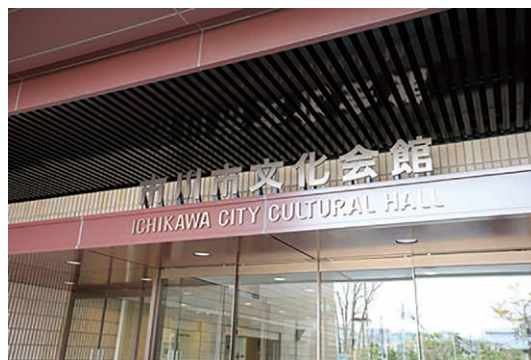
正面入口▷ (入口扉、館名ロゴ改修)
