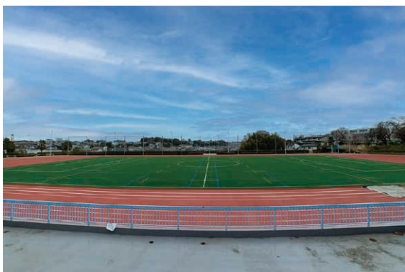
△市川市スポーツセンター陸上競技場改修工事後
