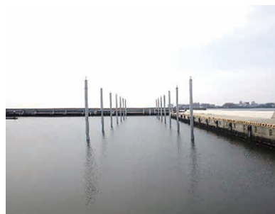
△西突堤側係留杭
