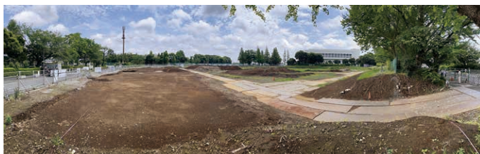
△旧施設解体後
