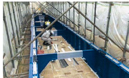
△施工中（主桁補修後）
