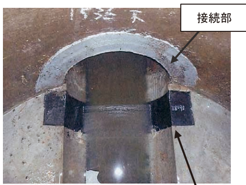
管口耐震化施工部
