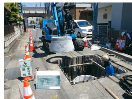
△マンホール設置工
