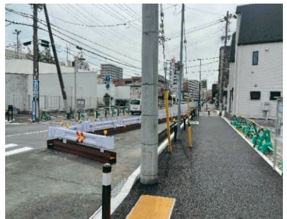
△完成（南側の歩道）
