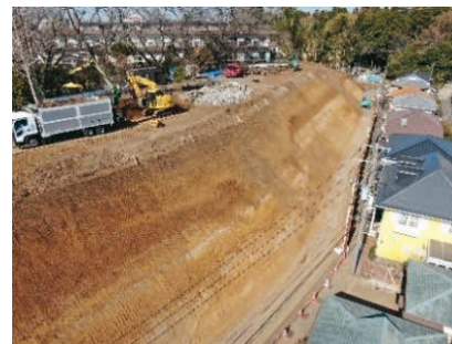
△施工中（令和6年2月完成予定）
