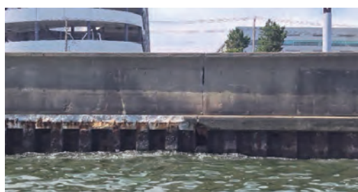
△欠損や鋼矢板の開孔が見られる防波堤
