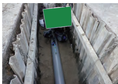
△下水道管渠布設工事（施工例）
