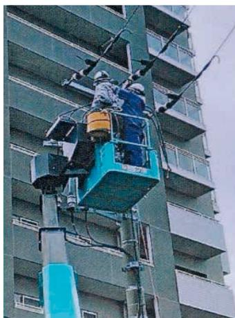
△高圧気中開閉器（PAS）の交換の様子
