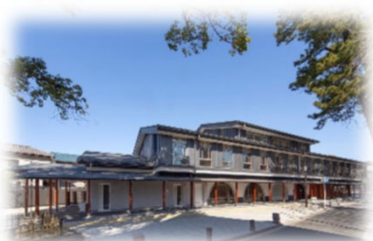
▲完成した八幡市民交流館 (愛称：八幡市民交流館 ニコット)
