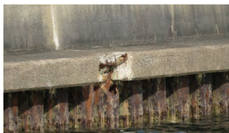
△欠損や鋼矢板の開孔が見られる防波堤
