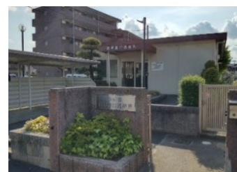
信篤窓口連絡所（築34年）
