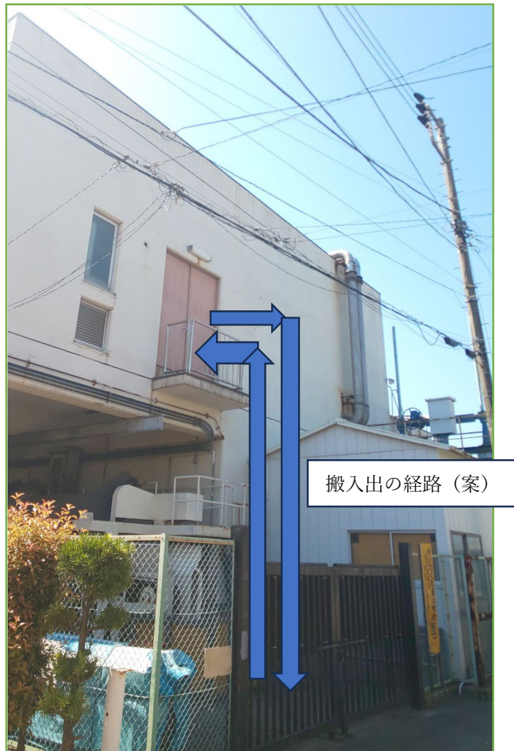
搬入出口の配置状況
