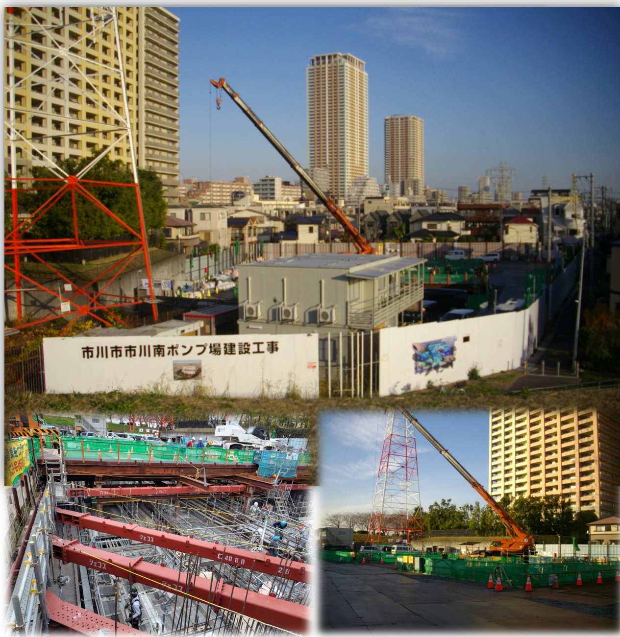
・市川南ポンプ場 建設工事
