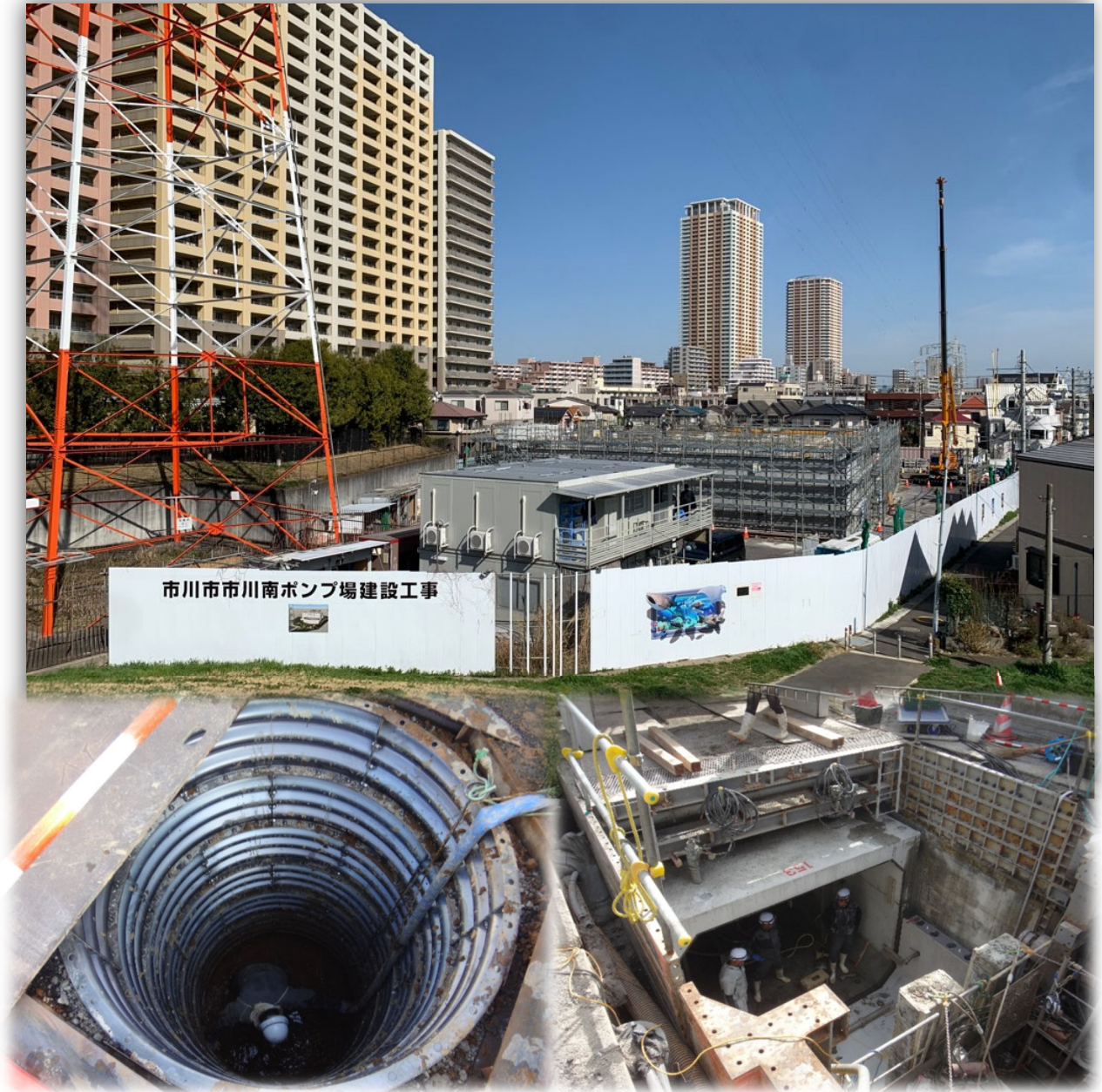
市川第4-4処理分区污水管渠布設工事
