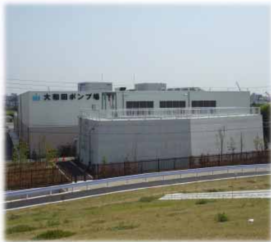
大和田ポンプ場
