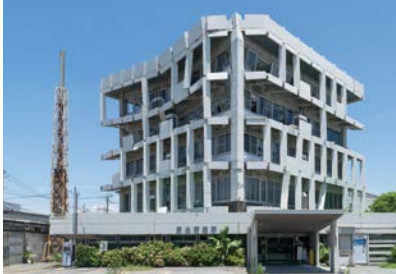
▲半壊となった宇土市役所
