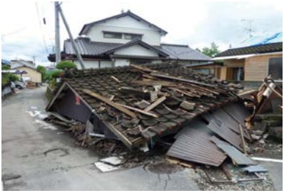
▲地震で倒壊した家屋
