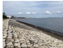
塩浜2丁目護岸の現況
