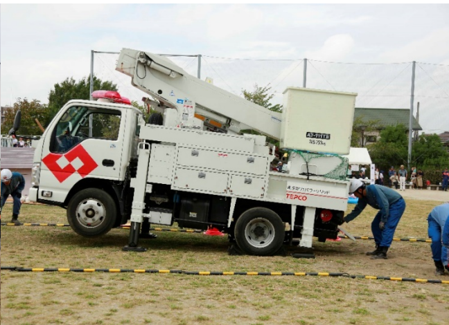
・ ガス管の復旧訓練
