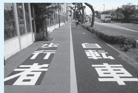
富貴島小学校東側歩道の路面標示新設
