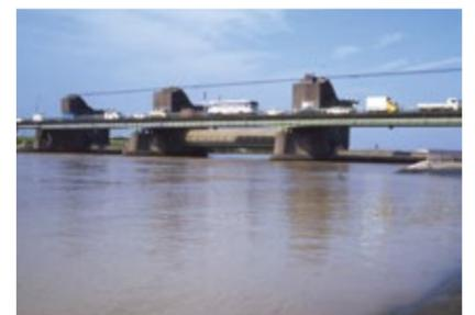
▲ローリングゲート時代の行徳可動堰と、かつての行徳橋。中央のゲートが持ち上がっている。
