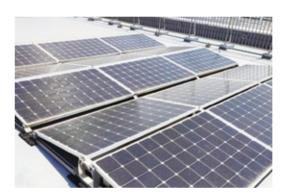
千葉商科大学では、多くの校舎の屋上に太陽 光パネルが設置されています。発電した電力 はパネルを設置した建物で優先的に使われ、 残りは他の建物に供給されます。
