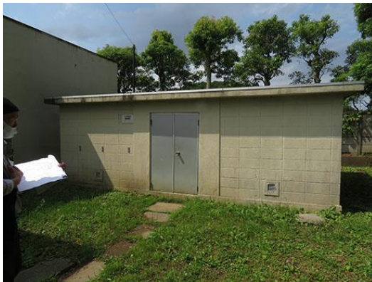
ガス整圧器室 状況写真
