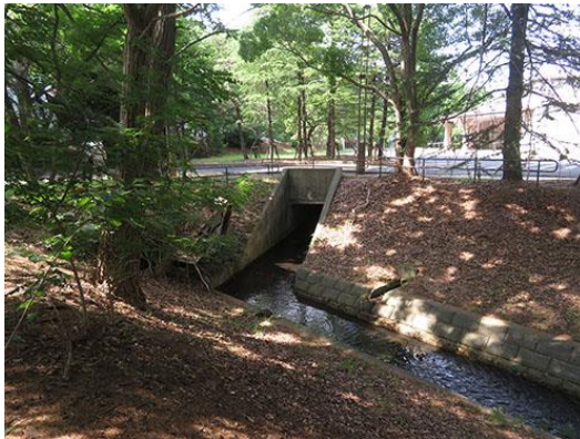
水路 状況写真
