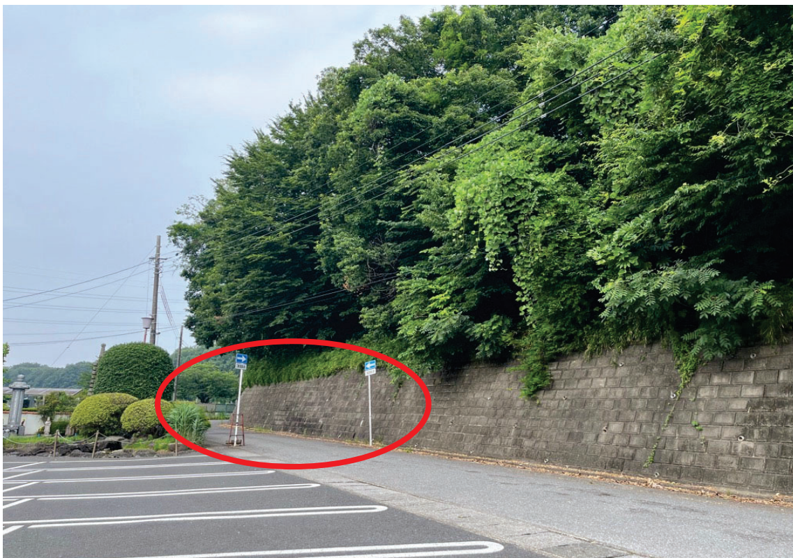
⑦斎場入り口（一方通行側） 通行止め箇所
