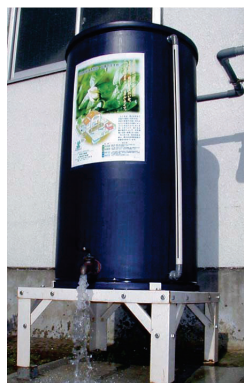
〈雨どい取付型貯留施設〉
