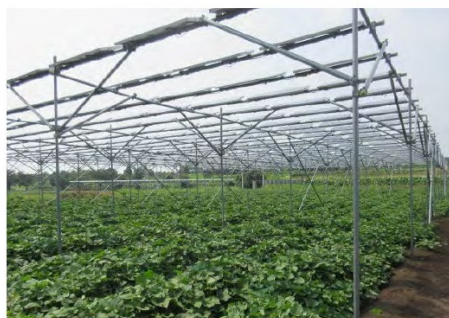
露地の畑の上部にパネルを設置
