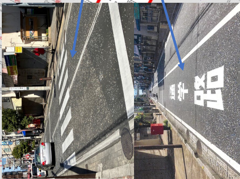
24 路面標示復旧(2箇所) 横断歩道塗り直し
