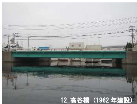
写真 2.1 建設後 50 年を経過する橋りょう
