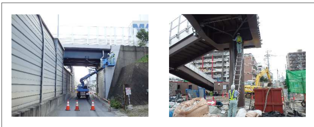
写真 5.1 定期点検状況
