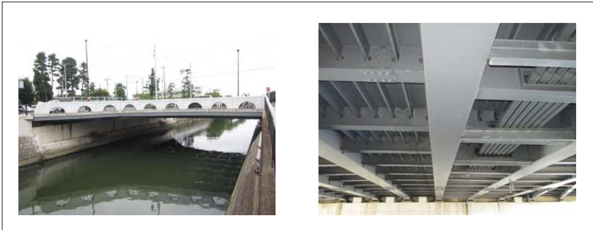
鋼橋：30_八方橋（単純鋼床版 I 桁橋、橋長 20.0m、真間川）
