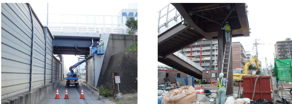
写真 5.1 定期点検状況
