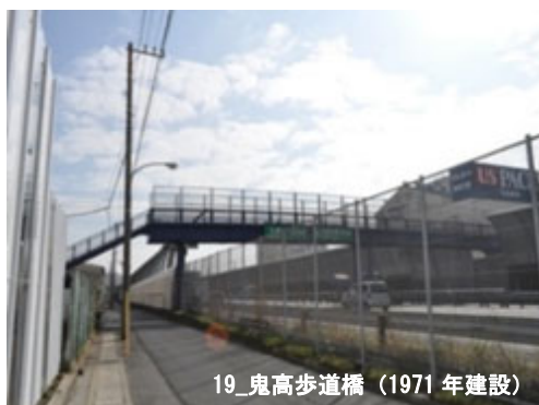
写真 2.1 建設後 50 年を経過する横断歩道橋
