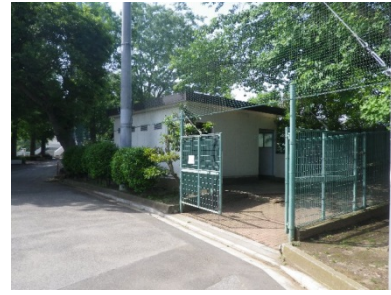
㉔野球場北東側トイレ
