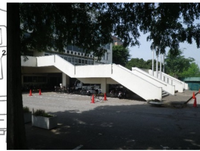
⑱体育館入口
