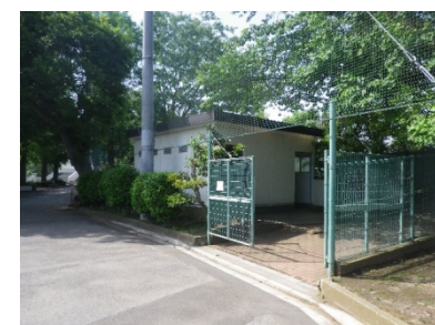
㉔野球場北東側トイレ
