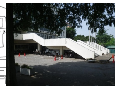
⑱体育館入口
