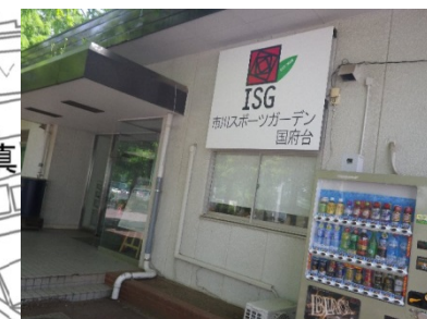
⑭陸上競技場管理棟はスポーツガーデン 国府台の事務所となっている
