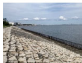
塩浜2丁目護岸の現況
