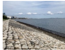
塩浜2丁目護岸の現況
