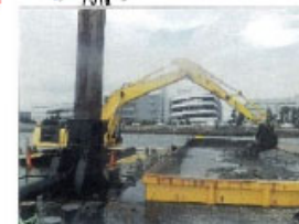
浚渫工事のイメージ
