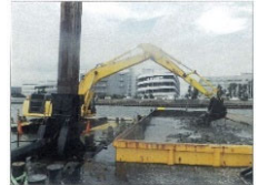
浚渫工事のイメージ
