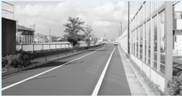
▲11月10日(木)に全線開通する都市計画道路3・4・18号
