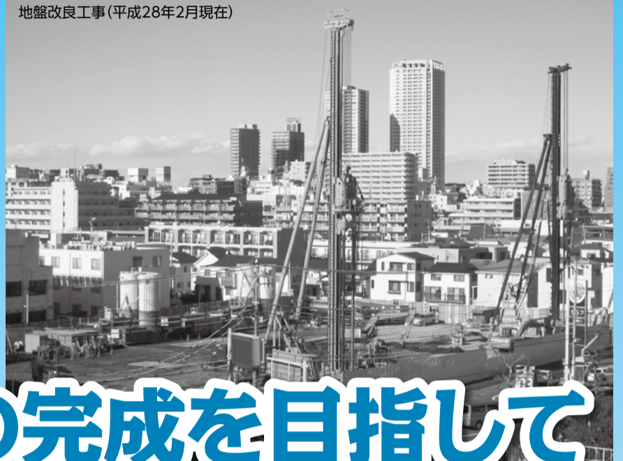
地盤改良工事(平成28年2月現在)
