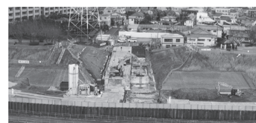
▶市川南ポンプ場の新設工事
