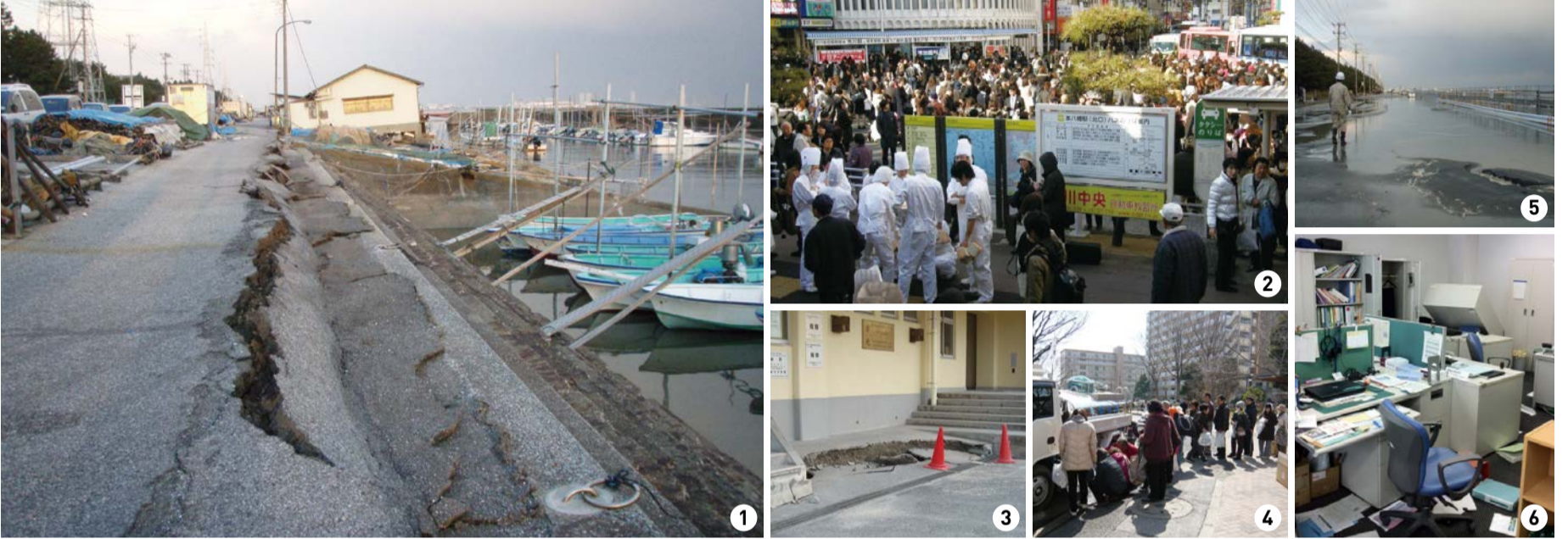
①大きく亀裂が入った塩浜護岸。②電車が止まり多くの人が集まる市内駅の様子(市川よみうり新聞社提供)。③校舎と敷地の間に段差ができてしまった小学校。④断水が発生した地区に給水車が到着し、給水を待つ住民。⑤液状化により土砂が噴出し通行が困難になった道路。⑥ロッカーや家具などが倒れ、中のものが散乱している様子。
