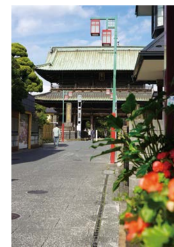
▲無電柱化した参道
