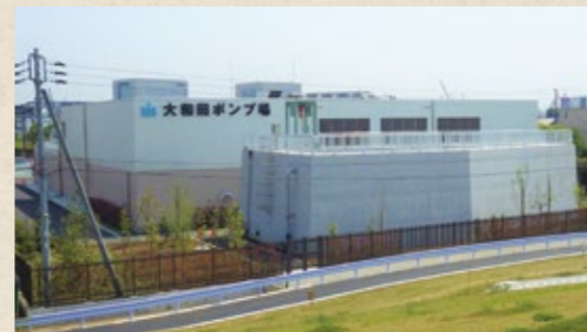
▲大和田ポンプ場
