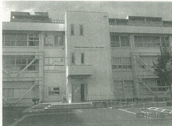
千葉県市川健康福祉センター(市川保健所) 新型コロナウイルス感染症の対策において重要な役割を担っている市川保健所は現在、千葉県の管轄下にある。中核市に移行すると、市管轄の保健所となり、市の危機管理体制と一体となって、自立した判断の下で適切かつ迅速なサービスの提供が可能になる。
