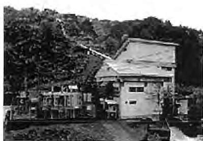
高田発電所(上越利水事務所HPより)
