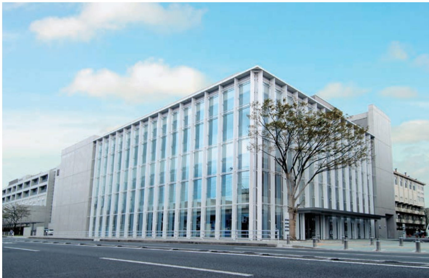
天井等の改修工事を予定している行徳公会堂(行徳文化ホール1&1)
