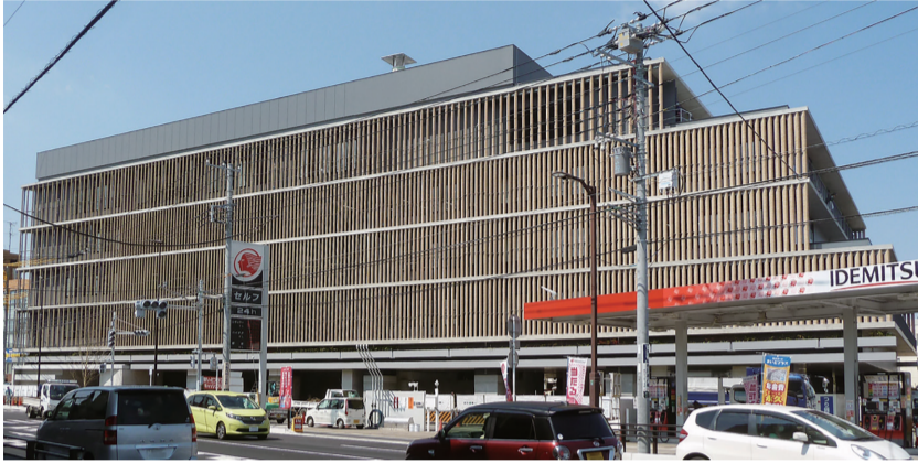
市役所仮本庁舎(南八幡2-20-2)
