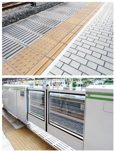
内方線付点状ブロックとホームドア
