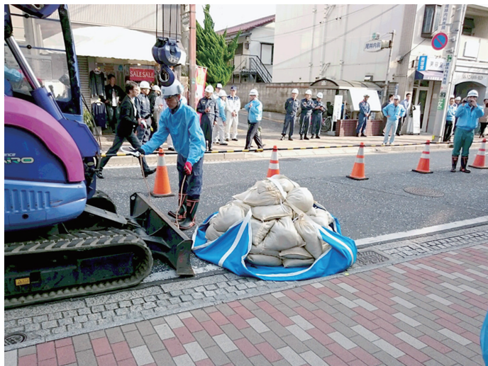
市川南ゆうゆうロードでの土のう積み訓練
