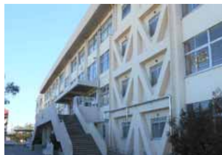
耐震改修の実施
