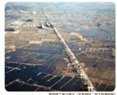
東西線工事の様子（写真提供：地下鉄博物館）
