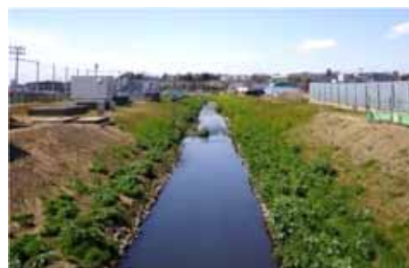
自然環境に配慮した河川改修
