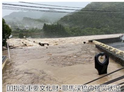
国指定重要文化財・耶馬溪橋の被災状況
