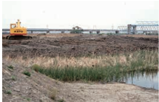
写真4-6-39 埋め立て中の行徳の湿地帯 湿地の後方に東西線の高架橋が見える。（1988年5月3日）
