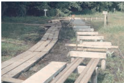
写真4-3-4 園路の新設工事 左が木製の園路。ほぼ地面の高さに設置されている。右が整備中のコンクリート園路。橋脚部分を作っているところ。(長田谷津 1980年10月 撮影：岡崎清孝)
