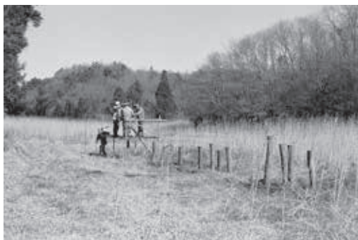
写真4-3-2 園路の設置工事 湿地を巡る園路を作るための杭を打ち込んでいる。(長田谷津 1974年2月10日 撮影：岩瀬徹)
